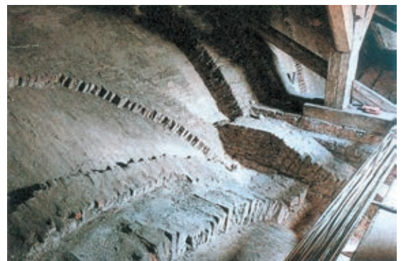
Abb. 9: Ehem. Benediktinerkirche Villingen Ausschnitt Dachstuhl und Gewölbeaufsicht (Gurtbogen zwischen Langhaus und Chor).
