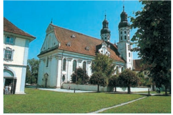
Abb. 7: Ehem. Prämonstratenserabteikirche Obermarchtal Außenansicht von Südwesten.
